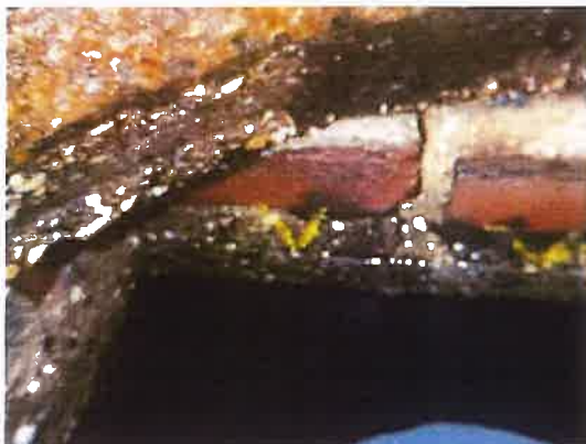
Foto 5: aanvang 2 e beproeving in de afdekplaat
